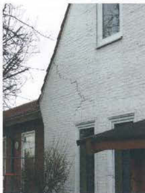
Kiga an der Steider Straße: Rissbildung deutlich erkennbar
